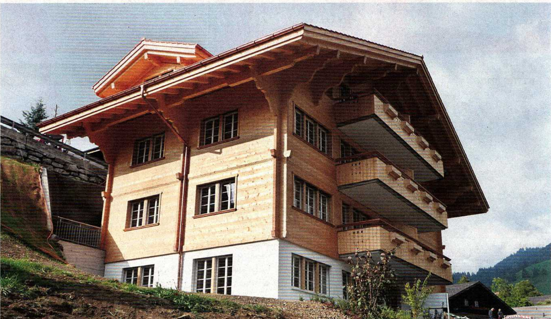
Der Chaletbau mit den sieben Alterswohnungen passt perfekt in das Ortsbild von Habkern.
