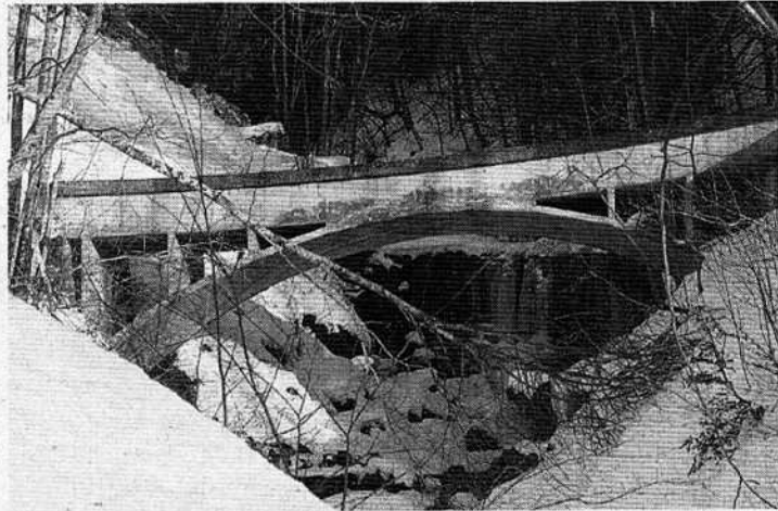
Die in einem Bogen mit einem Radius von 15 Metern angelegte Bohlbachbrücke diente als Prototyp und Vorgänger der international bekannteren Schwandbachbrücke. (bk)
