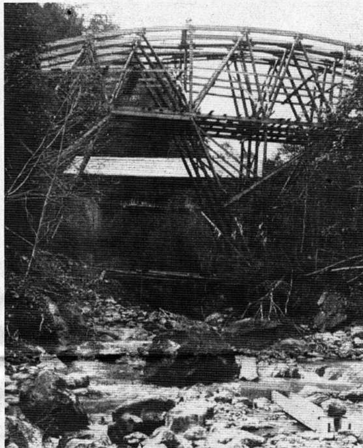
Anfangs Sommer 1932 wurden die Gerüste und Schalungen für die neue Traubachbrücke, welche die alte Holzbrücke ersetzte, erstellt. (Archiv IG Ortsgeschichte Habkern)
