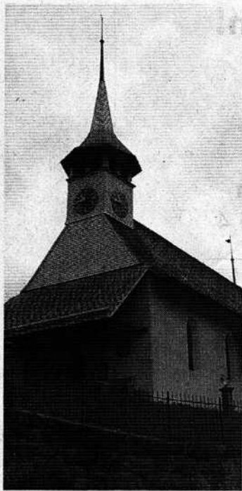
In neuem Glanz erstrahlt der Kirchturm. Die Sanierung kostete insgesamt 112'000 Franken. (ci)
